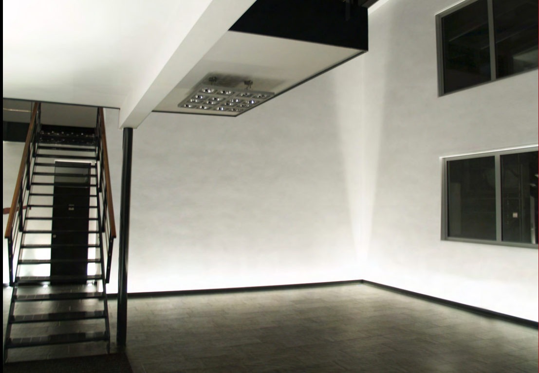
Fassaden- und Wandbeleuchtung mit in den Boden eingelassenen Led's Stripes
